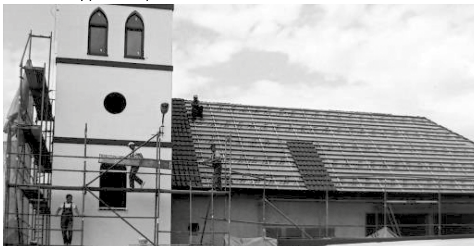
Montaż zegarów na wieży remizy 2014 r.
