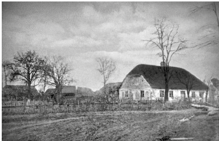
Dom Antoniego Kaszyńskiego i Antoniny Gęziak, następnie Tomasza Opasa i Antoniny Kaszyńskiej, a później Zofii Kaszyńskiej i Teofila Kaszyńskiego. Na początku XX w. mieściła się w nim Szkoła (4 sale lekcyjne)
