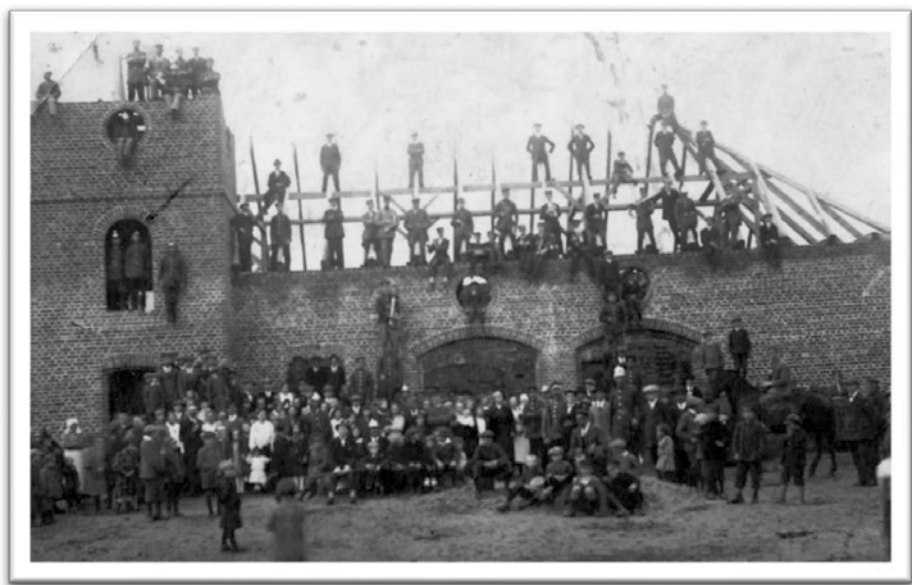
Remiza Straży Ogniowej w Brudzewie w trakcie budowy 1925 r.
